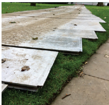
Slodzi izlīdzinošas pagaidu plāksnes no betona.
